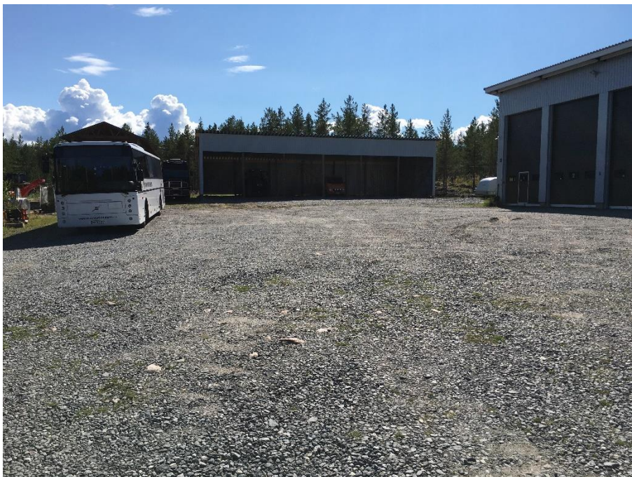
Revon turistiliikenteen varikon rakennuksia.
