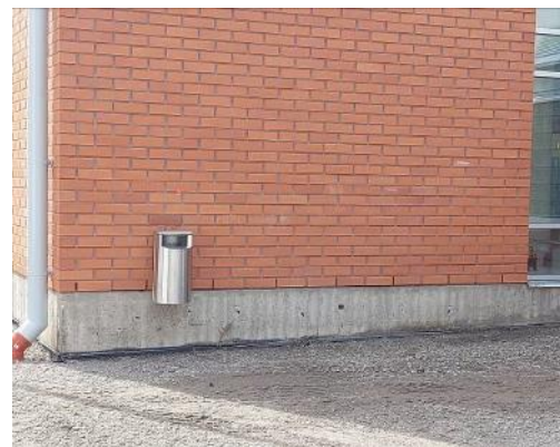
Kuva 11. Laajennusosan seinärakenne on tuulettuva
