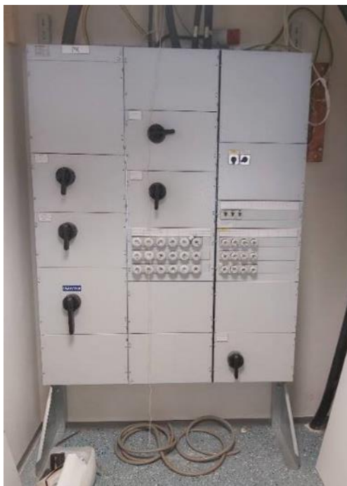
Kuva 112. Sähköpääkeskus.
