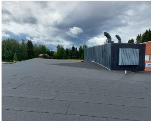
Kuva 58. Kattorakenteena on loiva pulpettikatto
