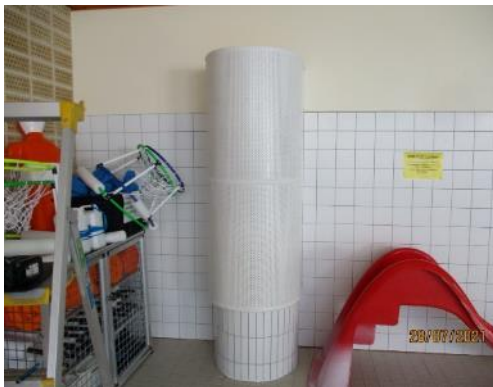
Kuva 96. Pääallastilassa oleva matalanopeustuloilmapäätelaitte.
