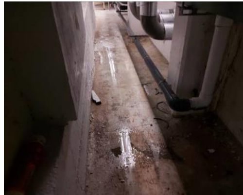
Kuva 48. Altaiden ollessa täynnä ison altaan ja lasten altaiden väliin lammikoituu vettä
