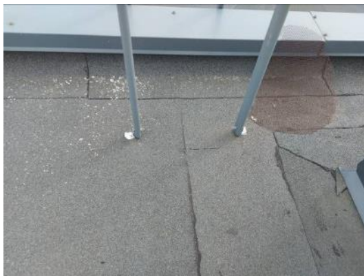
Kuva 62. Tikkaiden kiinnitys IV-konehuoneen vesikattoon.
