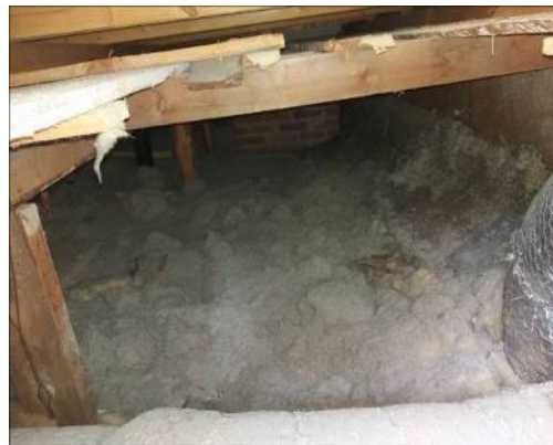
Kuva 54. Luukusta sivummalle on puhallusvillaa
