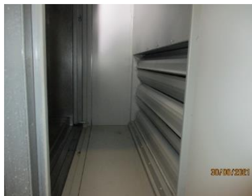
Kuva 69. Kaikkien IV-koneiden kammiot ovat pääosin hyväkuntoisia. IV-koneiden TK01 ja TK02 kammiot on pintakäsitelty niiltä osin, kun kammiot ovat alttiina allastilan ja pesu-huonetilojen kostealle poistoilmalle.
