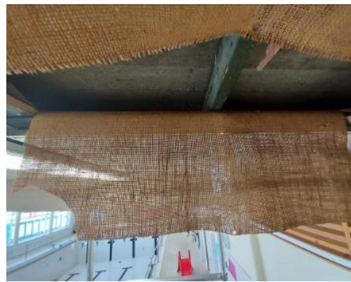
Kuva 56. Rakenneavaus lähemmin kuvattuna
