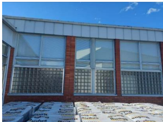
Kuva 17. Miesten pukuhuoneen ikkuna ulkopuolelta
