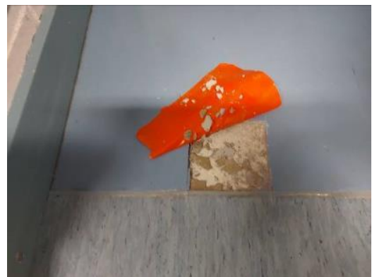
Kuva 23. Uimavalvojan huoneen rakenneavaus
