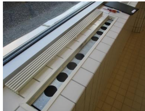
Kuva 91. Pääallastilan ikkunapenkeissä olevat säleiköt ovat vielä toimintakuntoiset.
