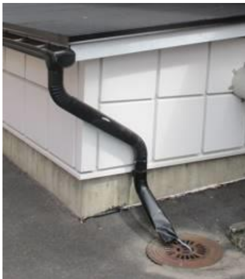
Kuva 124. Ränni vaurioitunut.
