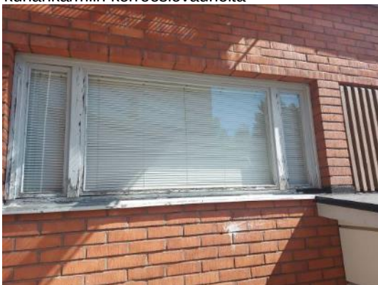
Kuva 16. Naisten pukuhuoneen ikkuna ulkopuolelta
