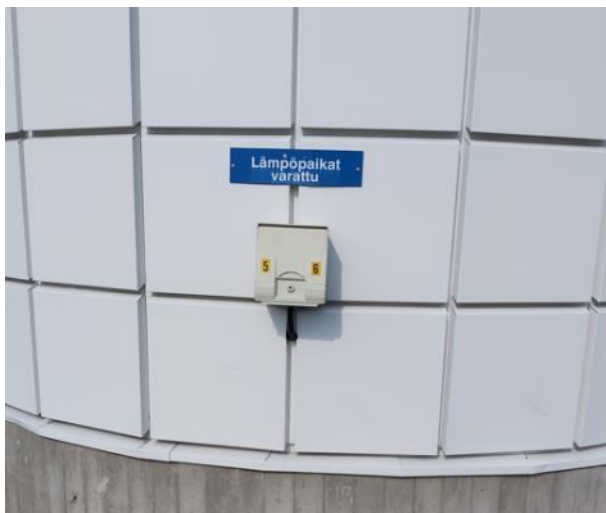
Kuva 111. Autonlämmityspistorasia ulkoseinällä.
