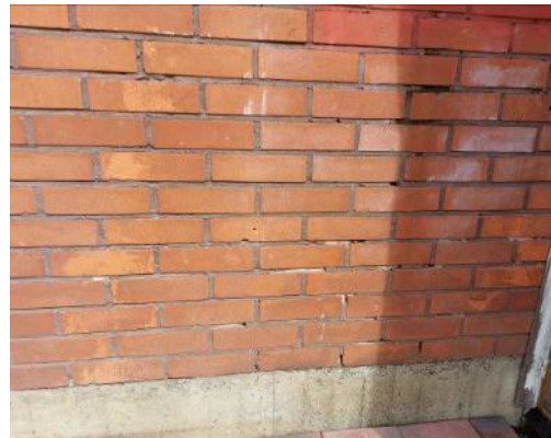
Kuva 9. Jälkisaumauksia on rapautunut pois ja tiilissä on pintarapautumaa
