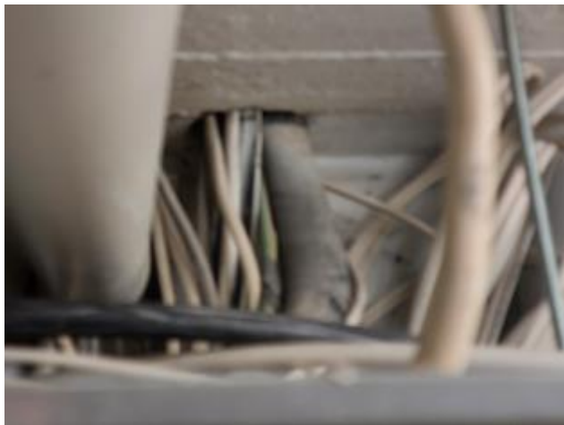
Kuva 118. Kaapeliläpiviennit tulisi tiivistää.
