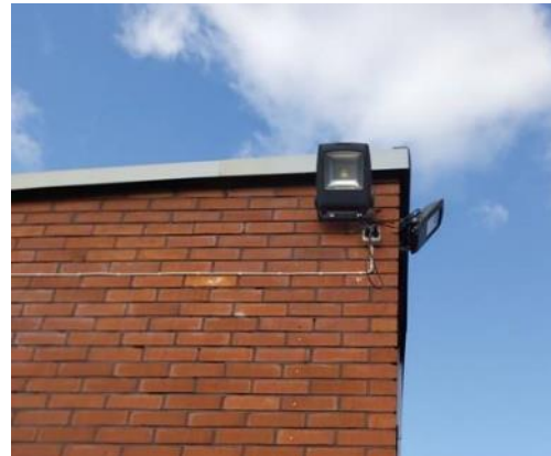
Kuva 110. LED-valonheittimiä ulkoseinällä.
