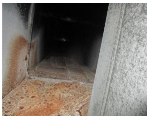
Kuva 87. Altaiden alatilassa oleva tuloilman runkokanava sisäpuolelta kuvattuna.
