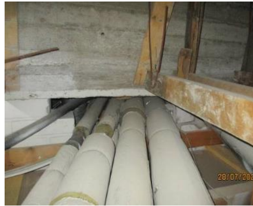
Kuva 25. Alaslaskun runko on kiinnitetty harjateräksin yläpohjan betonilaattaan
