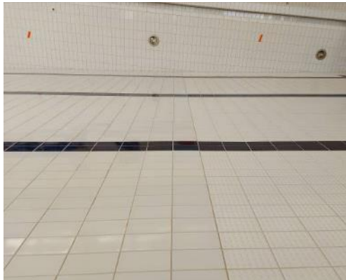
Kuva 33. Ison altaan laatoitukset ovat kiinni ja ehyet
