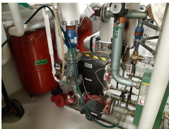
Kuva 1. Lämmönjakokeskus
