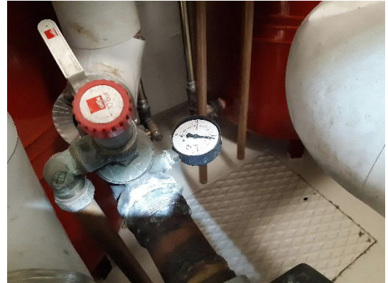
Kuva 6. Painemittarista puuttuu lasi
