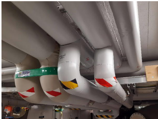
Kuva 7. Putkieristeet ovat muovipintaisia villaeristeitä
